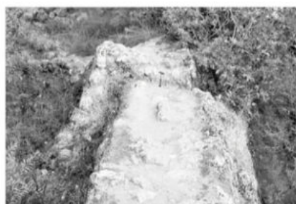
Рис. 9. Смещение римского акведука на Миссиафском субсегменте возле г. Аль-Хариф и в результате сейсмических разрушений в крепости Крак де Шевалье: а — план смещения акведука ([9], с поправками); б — акведук, смещенный на 10 м по главному разлому (А—В) и на 1–1,5 м по сопутствующему более мелкому разлому (С—D); в — смещение на 0,75 м по параллельному мелкому разлому (Е—F); г — крепость Крак де Шевалье, круглая Южная башня была построена в конце XII века на развалинах прямоугольной башни, разрушенной во время землетрясения 1170 г.
