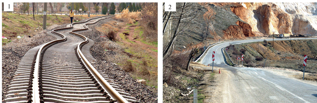
Рис. 8. Левосдвиговые смещения по EAFZ северо-восточнее области максимальных смещений: 1 — деформация и левосдвиговое смещение на 5.7 м железнодорожного полотна (т. 10 на рис. 5 и рис. П-3 в Приложении); 2 — сдвиг на 5.35 м дорожного полотна (т. 3 на рис. 5 и рис. П-5 в Приложении).
