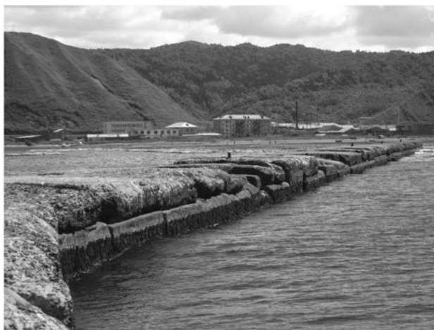
Рис. 6.19. Центральный бенч: – южный мол с морской капустой в нижней части западной стенки (фото С.А. Чиркова).
