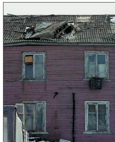
Провал дымохода на крыше деревянного дома в с.Тиличиха.
