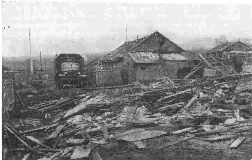
Рис. 8. Дом, разрушенный при землетрясении 1958 г. на одном из Курильских островов
