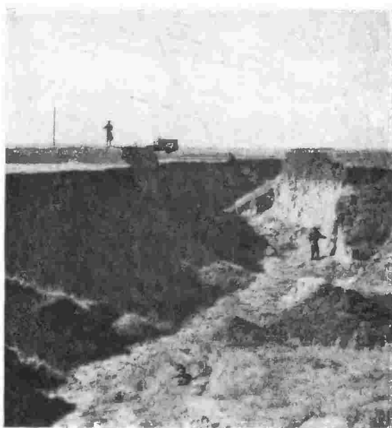
Рис. 2. Быстро растущий овраг на Средне-Русской возвышенности. Овраг уже дважды прорезал дорогу (видны две прорезанные насыпи). Дорога (на ней автомобиль), огибая растущий овраг, с каждым годом отступает все дальше к водоразделу
