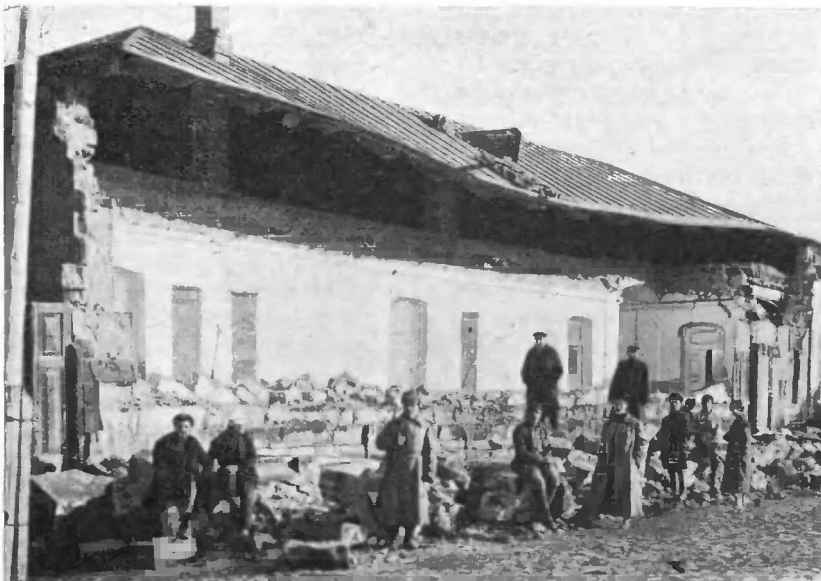
Рис. 4. Разрушенная западная стена здания детского приюта в Лениакане.
