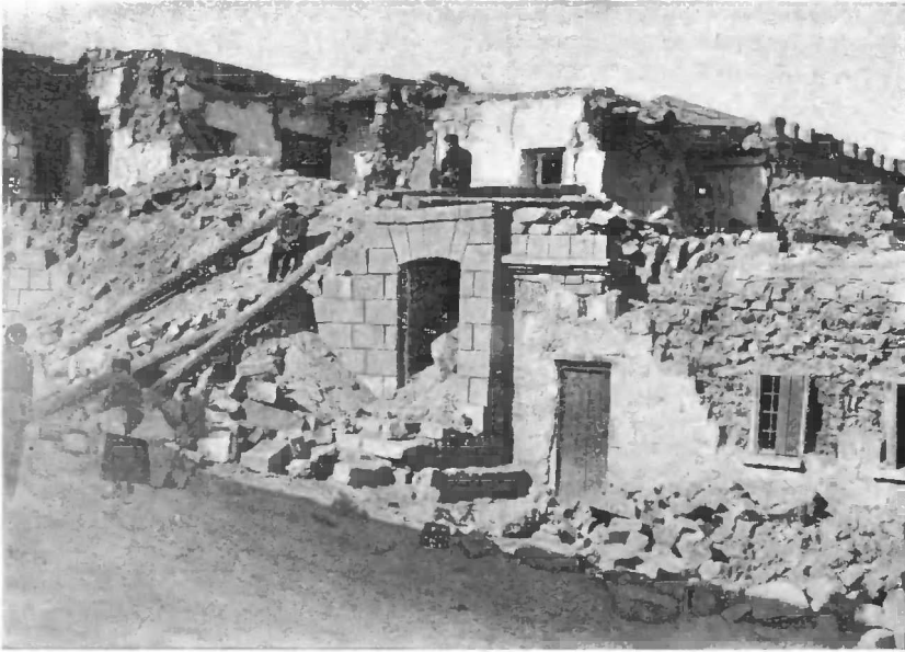
Рис. 3. Разрушения на 23-й улице Лениакана (бывш. Б. Слободская).
