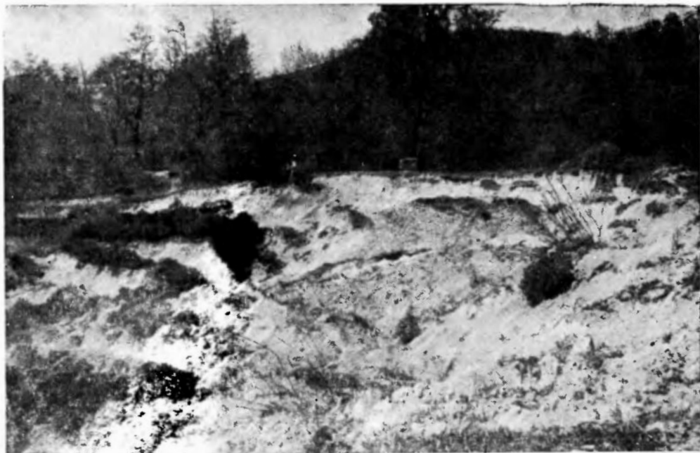
Рис. 1. Головная часть оползня со стенкой отрыва (район пос. Лео)
