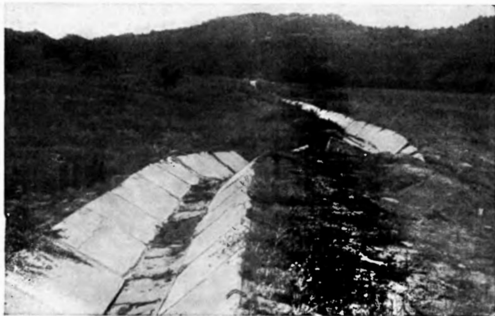
Рис. 2. Деформированная оползнем водоотводная канава в верховьях р. Малая Херота
